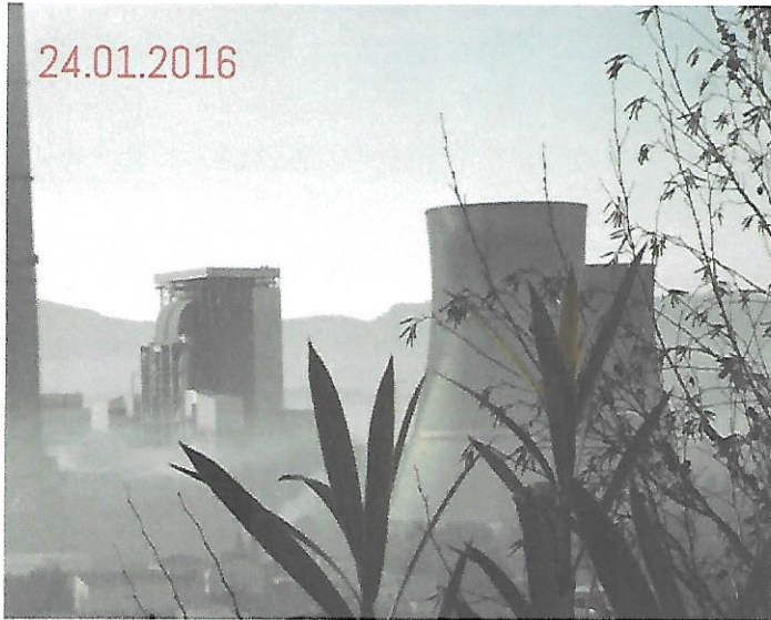
Poussières de cendres autour de la centrale et des réfrigérants.
