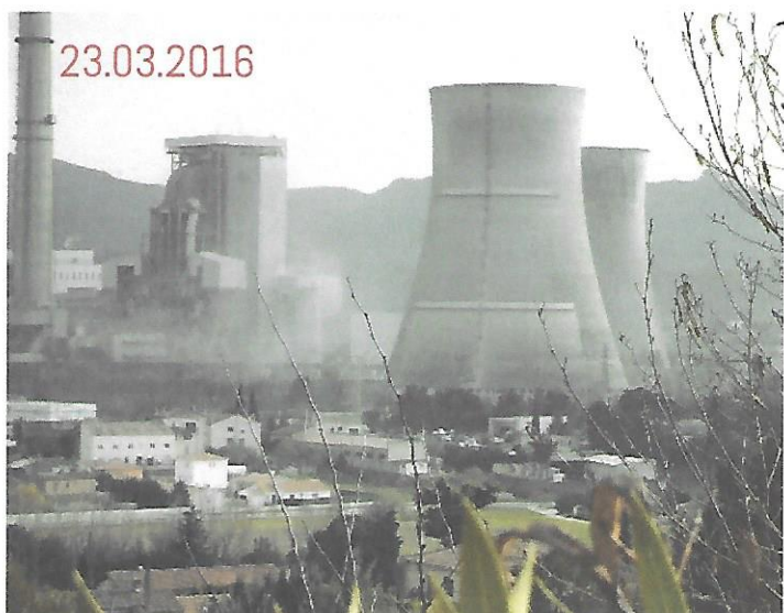
Poussières de cendres autour de la centrale et des réfrigérants.
