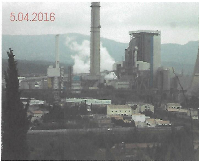
Dégagement de vapeur polluante tranche 4.
